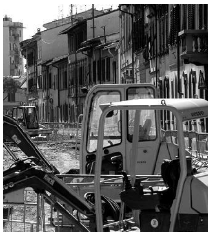
Uno dei cantieri della tramvia in città
