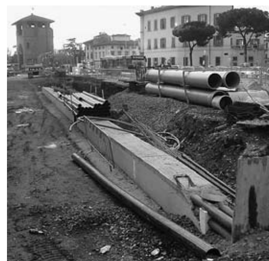
LAVORI Il cantiere della tramvia a Porta al Prato. Le 13 mila firme per il referendum hanno riaperto il dibattito
